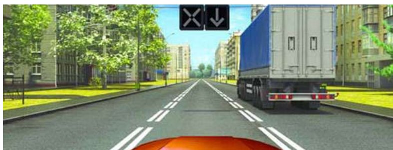
Рисунок 26 – Разметка 1.9 (полоса для реверсивного движения)
