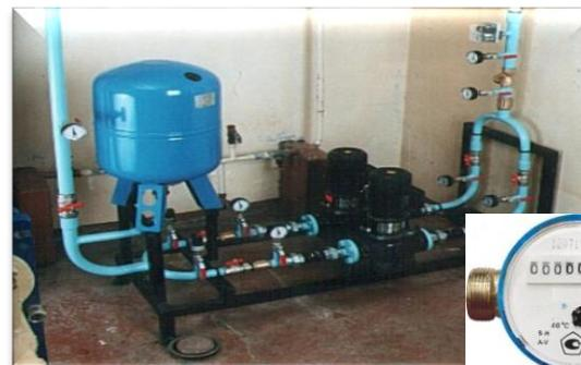
Установка узлов учета с импульсным выходом и насосов-повысителей в домах
