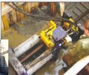
Метод протаскивания в старый трубопровод новой полиэтиленовой трубы меньшего диаметра
